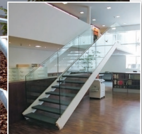
Stahlterasse mit Glasbrüstung (Bibliothek Ferdinandeum, Innsbruck)
