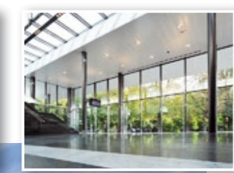
Innenansicht Stahlfassade mit Alu-Dachverglasung Schüco FW 60 (Congress Innsbruck)
