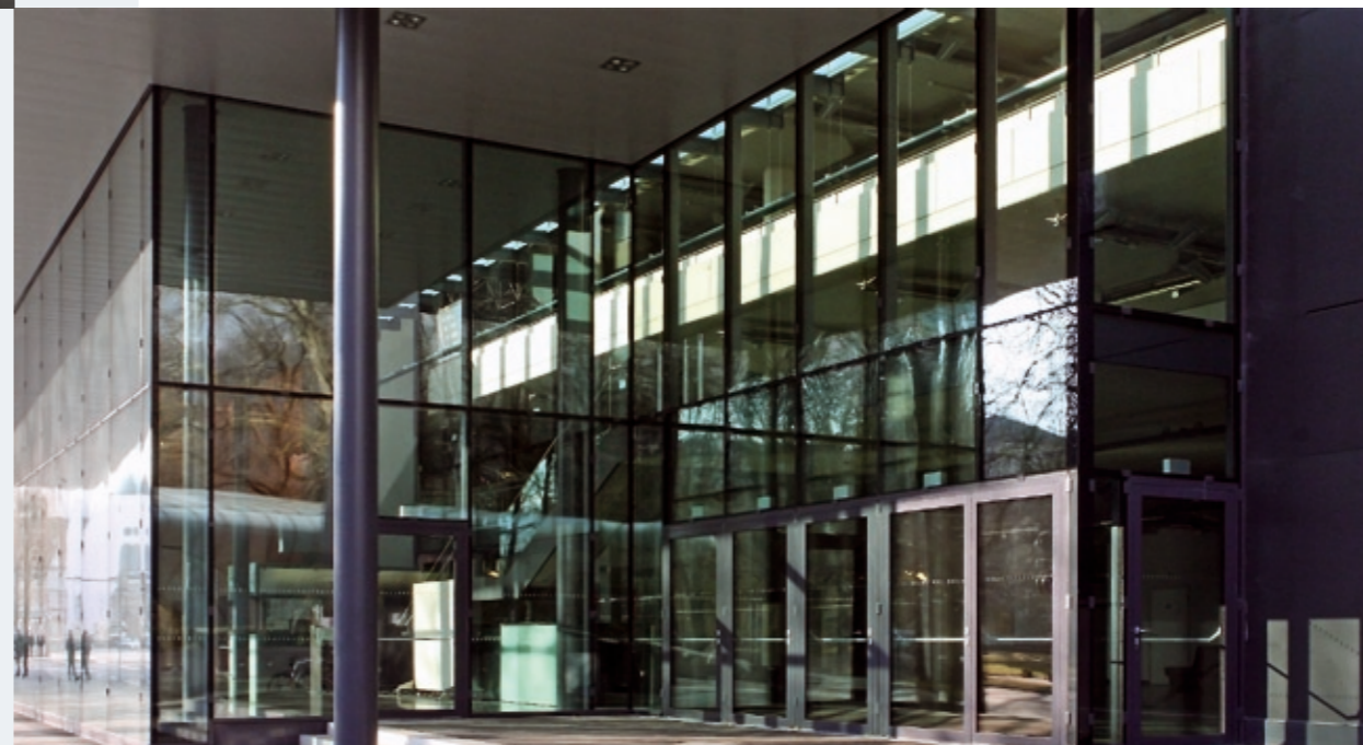
Stahl-Glas-Fassade (Congress Innsbruck)
