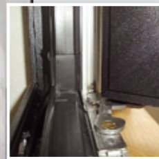
Detail: Verdeckt liegender Fensterbeschlag
