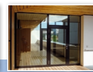
Alu-Element mit fixen Seitenteilen (SZ Vomp)
