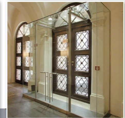
Nur-Glas-Konstruktion (Ferdinandeum, Innsbruck)
