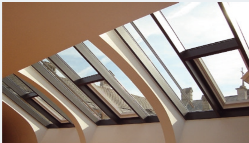
Schrägdachverglasung mit Dachflügel
