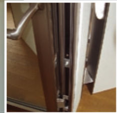
Brandschutzelement mit verdeckt liegenden Beschlügen
