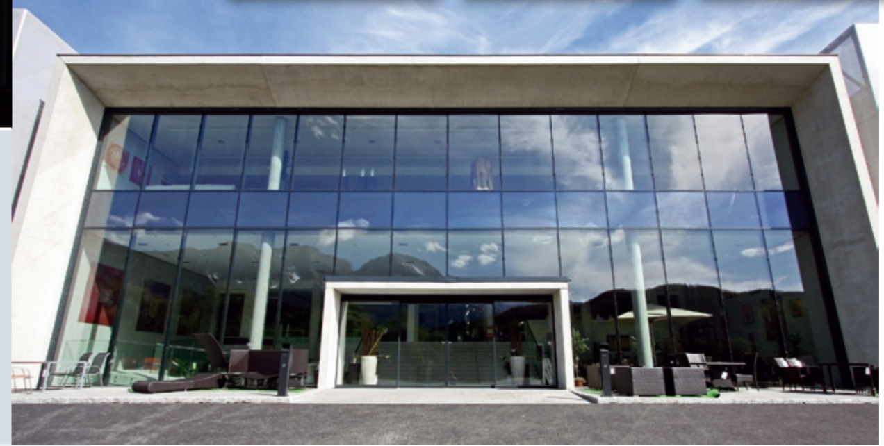
Aluminium-Glas-Fassade (Firmengebäude Föger, Telfs)
