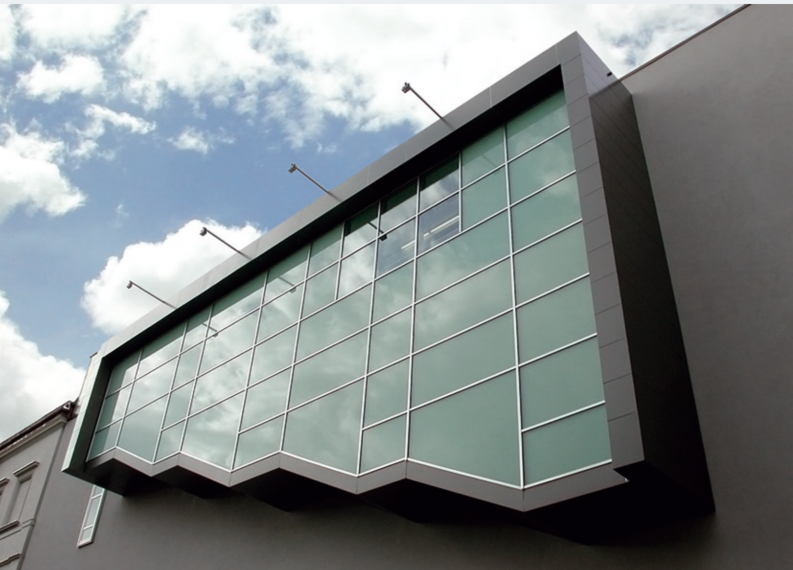
Stiegenhausverglasung mit Alucobondverkleidung (Ferdinandum Innsbruck)
