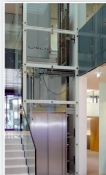
Liftschachtverglasung, punktgehalten (Hypo Tirol, Innsbruck)
