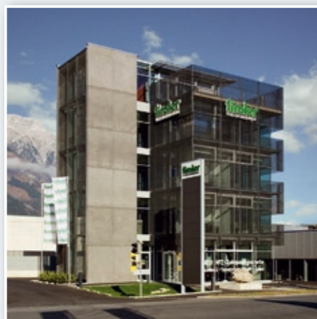
Alu-Glas-Fassade mit vorgesetzter Gitterrostfassade und Putzstege (Tiroler Versicherung, Innsbruck)
