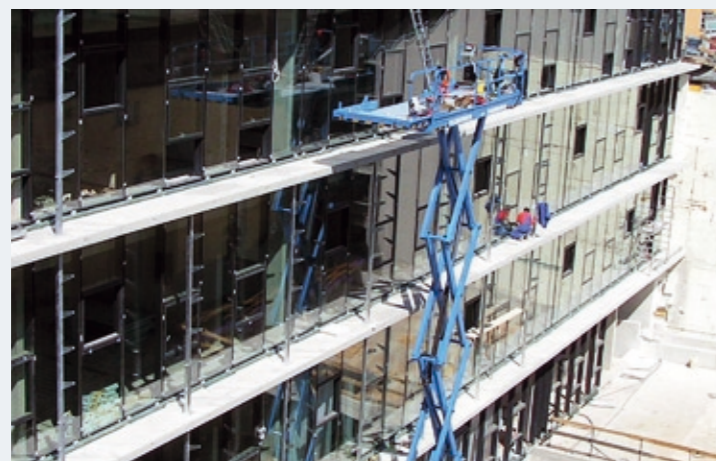
Aluminium-Glas-Fassade (Innenhof Akademisches Gymnasium Innsbruck)
