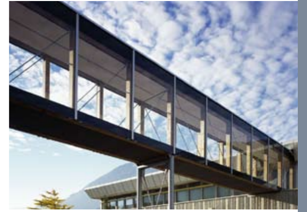
Firma Adler Lacke, Schwaz
